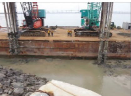
인천항 국제여객부두 1단계 건설공사 중 호안기초
