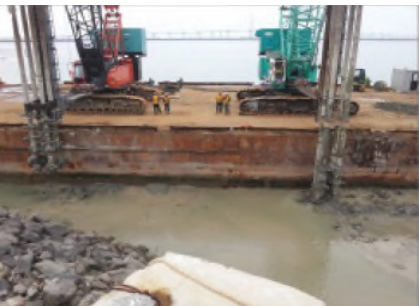
인천항 국제여객부두 1단계 건설공사 중 호안기초
